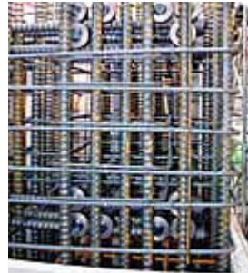
EG 定着板施工例
